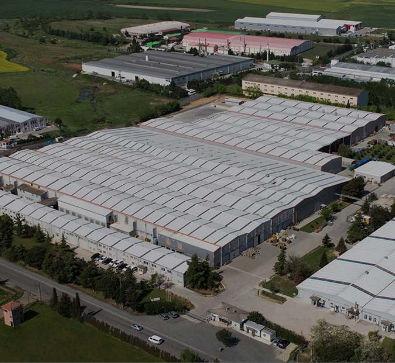
Termo Teknik Çorlu Üretim Tesisleri
