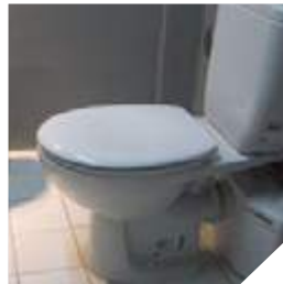
Klozetin arkasına monte edilmiş SANIPRO XR
