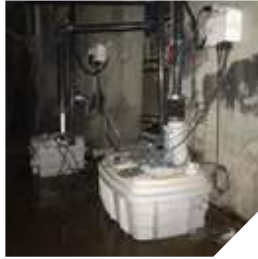
Soyunma odaların arkasındaki depo bölümü
