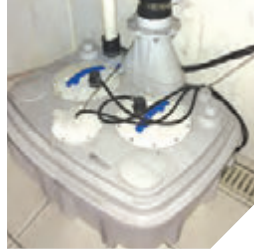
-2. kattaki depoya kurulan SANICUBIC 2 VX
