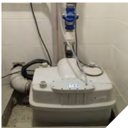
Montajı yapılmış SANICUBIC 2 Classic
