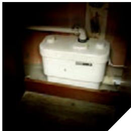
Tezgahın altına gizlenmiş SANIVITE pompa
