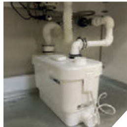
Lavabo altına kurulan SANIVITE
