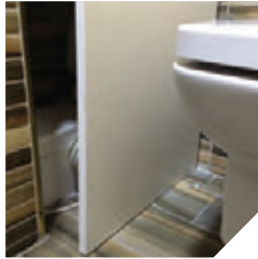
Lavabo altına gizlenmiş SANIFLO
