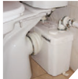
Klozete monte edilmiş SANITOP
