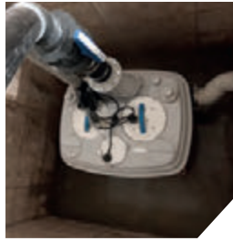
Kuyuya yerleştirilen SANICUBIC 2 VX
