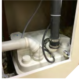
Alçıpan içine gizlenmiş SANICUBIC 1 WP
