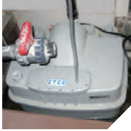
Makine odasına kurulan SANICUBIC 2 Classic
