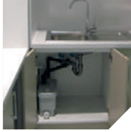
Mutfak dolabına yerleştirilmiş SANISPEED
