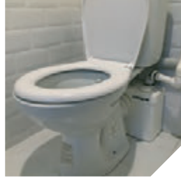
Klozetin arkasına monte edilmiş SANITOP
